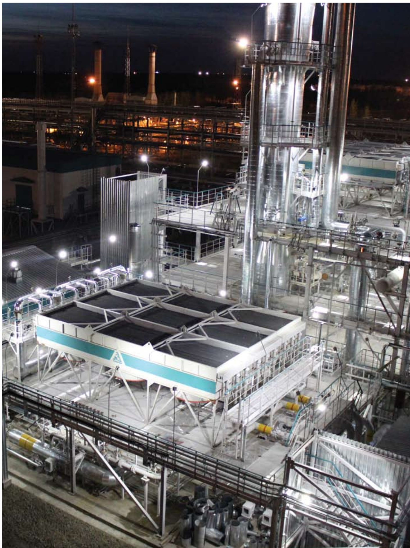
Блок турбодетандерных агрегатов для выработки широкой фракции легких углеводородов на Южно-Балыкском газоперерабатывающем комплексе. Построен холдингом «Промстрой» в 2011–2012 годах для «Сибура»
