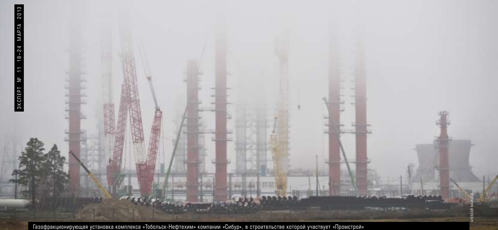
Газофракционирующая установка комплекса «Тобольск-Нефтехим» компании «Сибур», в строительстве которой участвует «Промстрой»
